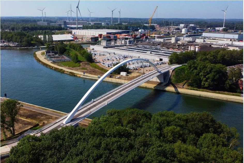
Radfahrerbrücke (Fietserbrug) in Tessenderlo (Belgien) - Entwurf von Architects Zwarts & Jansma ©
