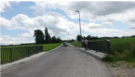
Die neue Brücke über den Affinger Bach in Gebenhofen mit 40 Tonnen Tragkraft.
