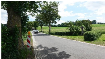
Die verbreiterte und neu asphaltierte Straße über den Miederinger Berg
